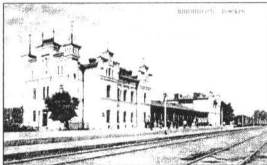
Железнодорожный вокзал в Кишиневе.
