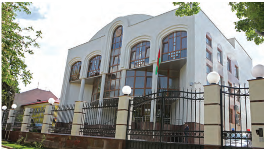
Новое здание посольства Республики Беларусь в Республике Молдова (построено под руководством посла В. А. Саковича в 2008 г.)
